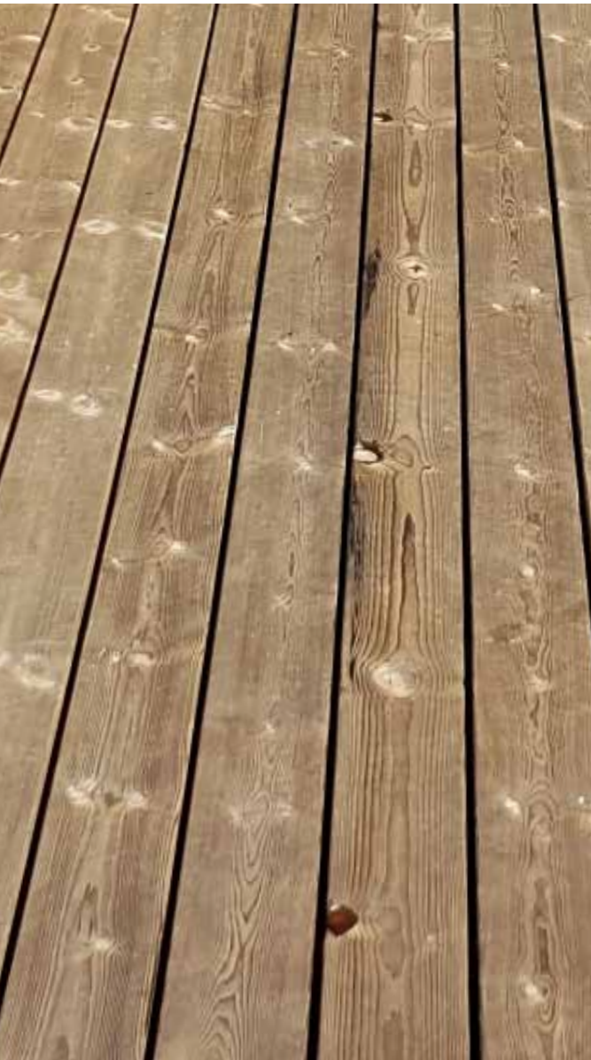
Terrassendeck aus Kebony Character neu verlegt (Bild links, 2019) und nach drei Jahren (Bild rechts, 2022)
