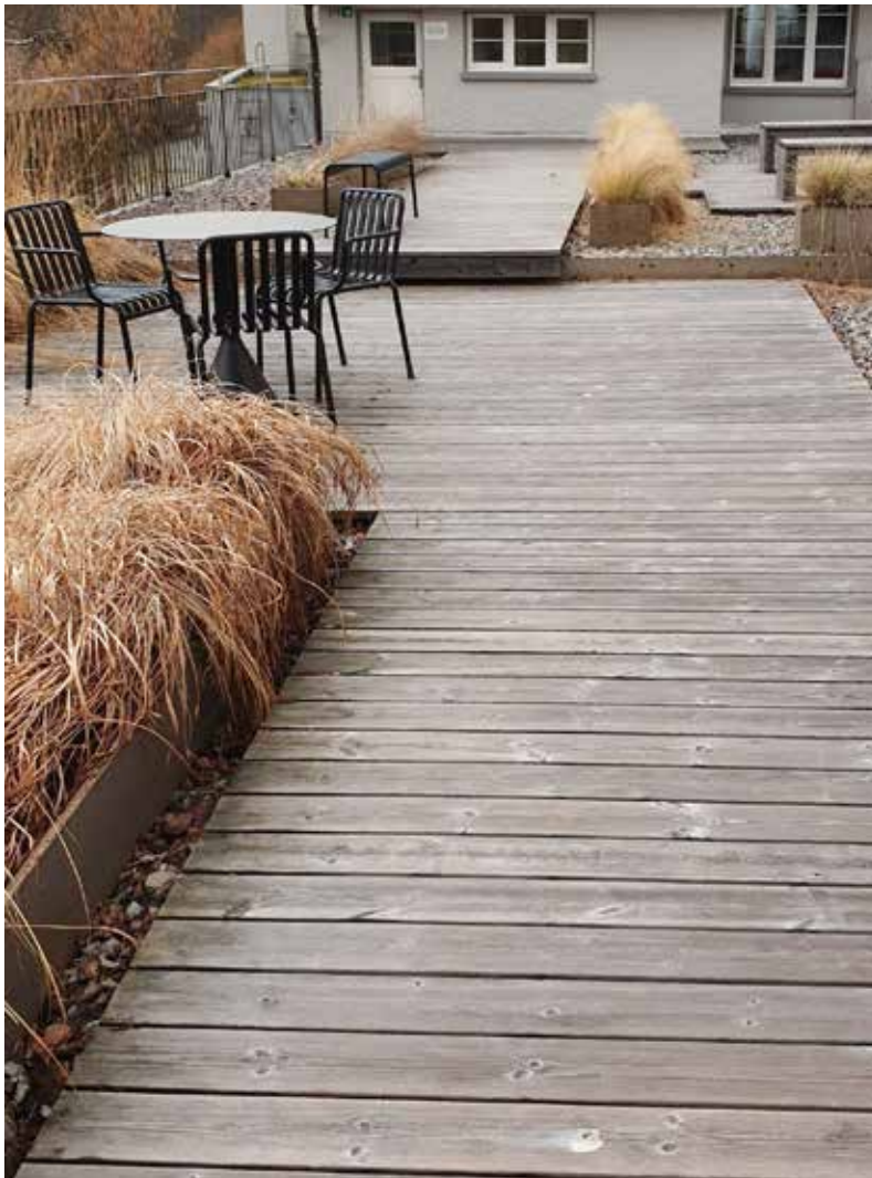
Das Terrassendeck aus Kebony Character nach einem Jahr Bewitterung im 2020. Durch Sonne und Regen hat das Holz bereits eine natürliche, leicht silbergraue Patina.
