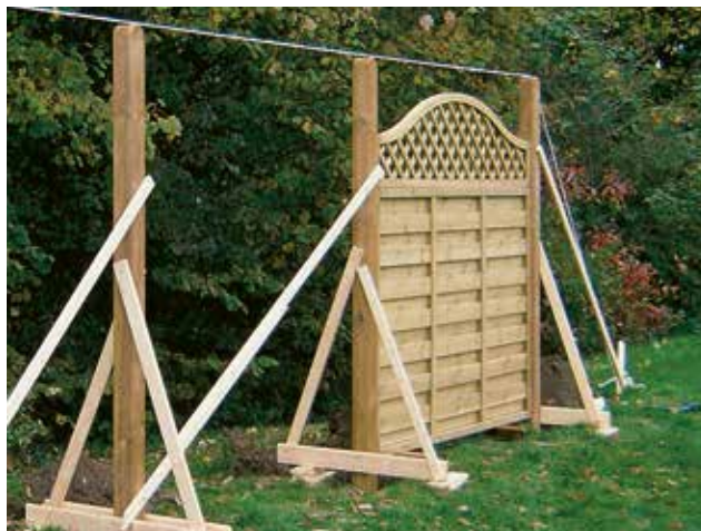
Die genaue Längsausrichtung klappt mit einer Spannschnur.
