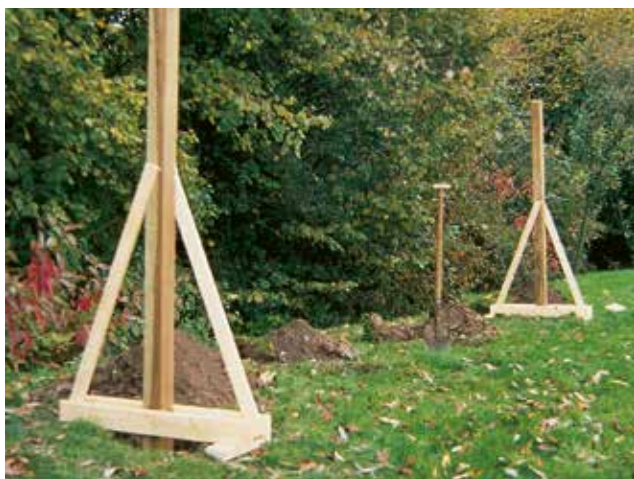
Aide au montage pour aligner les modules pare-vue.
