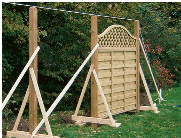
L'alignement longitudinal précis est tout à fait possible avec un fil à tendre.
